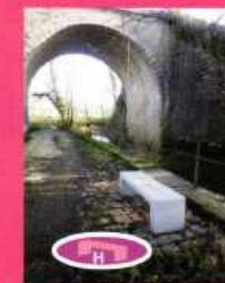
Sous la voie SNCF H
